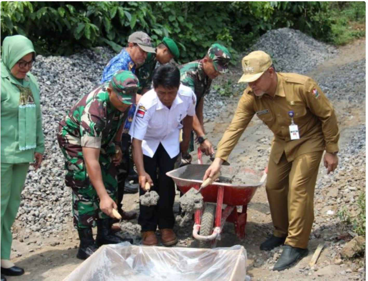
Simbolis Pengecoran Pertama Betonisasi
