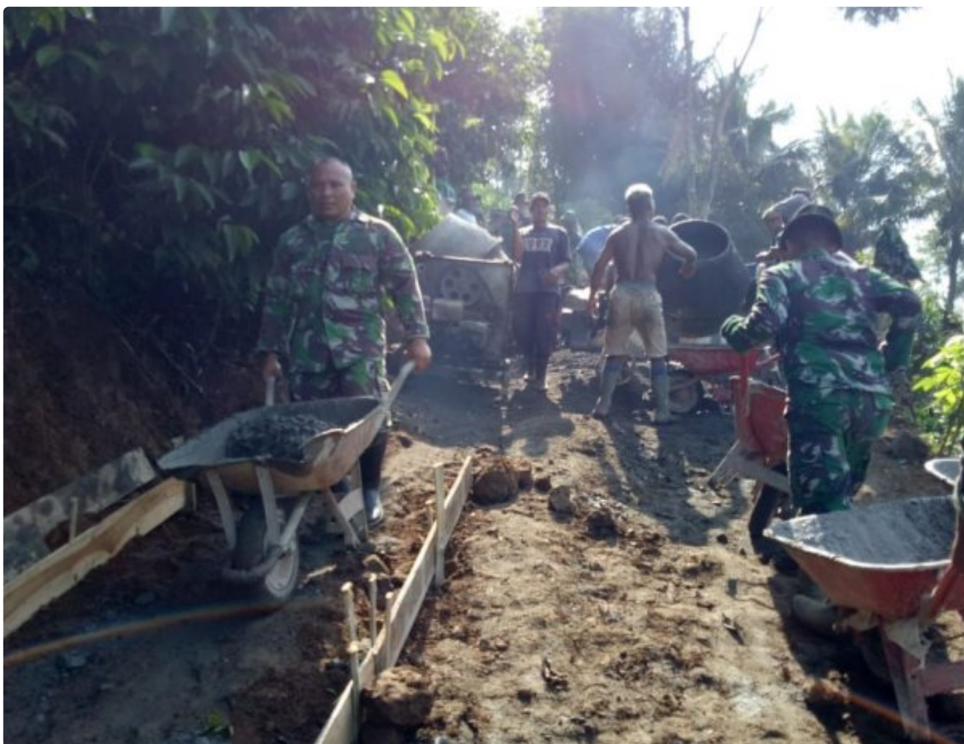
Satgas TMMD Kebut Pengecoran Jalan
