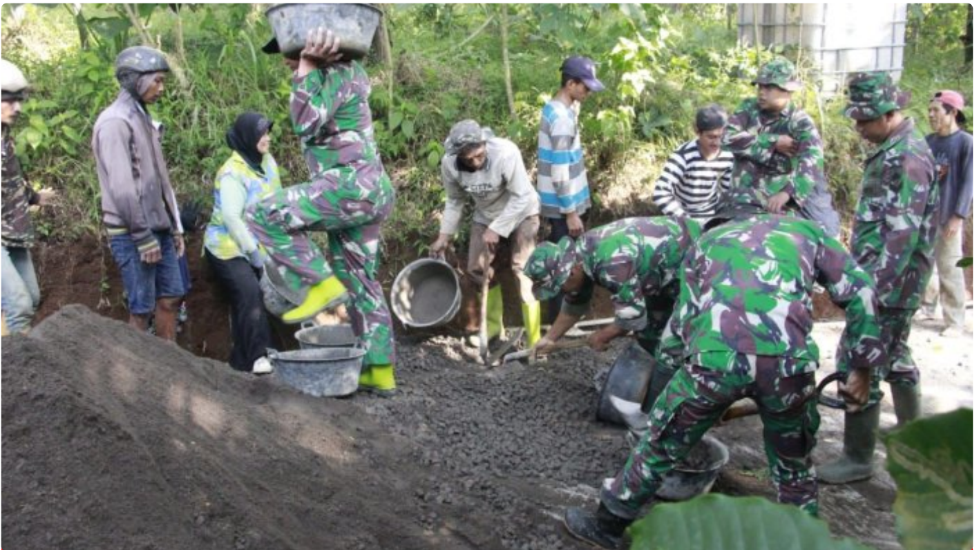
Warga Dan Satgas TMMD Bahu Membahu Kebut Pengerjaan sasaran Pengecoran Jalan
